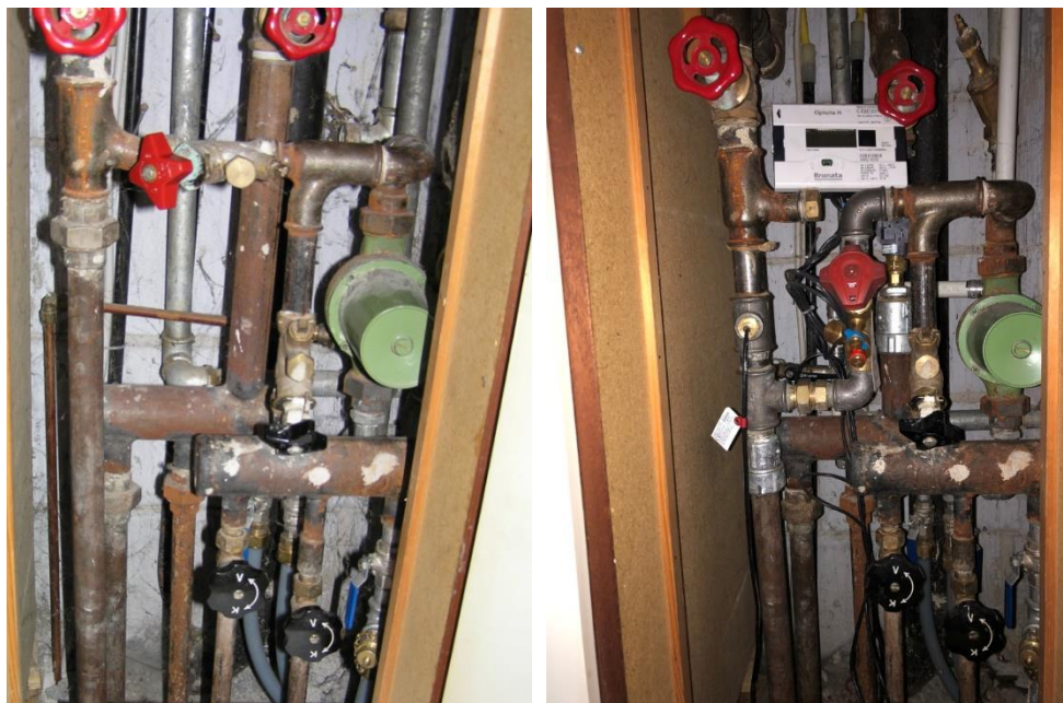
Installation hos Krokusvej 8 - før og efter montage af varmeenergimåler
